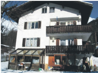
Das zu renovierende Haus, vor der Generalsanierung.
